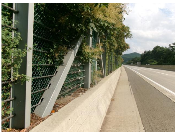
도로, 낙석방지울타리 전경
