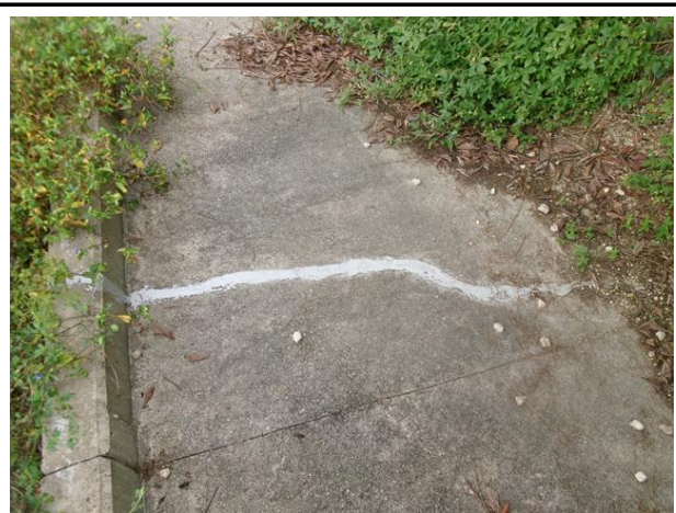
소단배수로 기보수 양호
